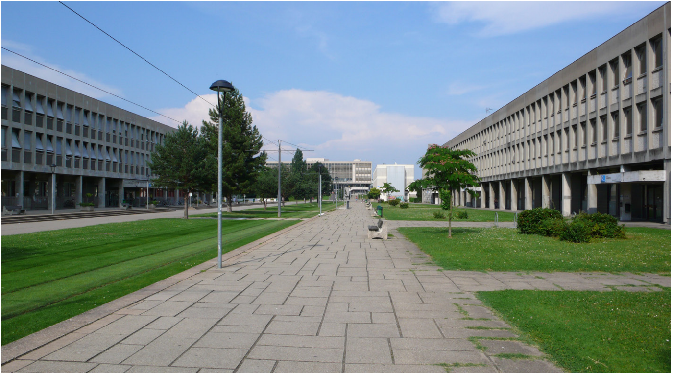
Vue perspective en direction de la bibliothèque depuis l'entrée principale de la faculté des Sciences. Le site propre du tramway traverse le site aujourd'hui d'ouest en est.
