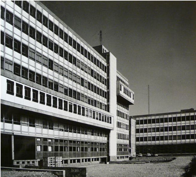
Jacques Perrin-Fayolle, INSA campus de Lyon La Doua, bâtiment de Physique Source : Dossiers DAU IFA - Cité de l'Architecture et du Patrimoine
