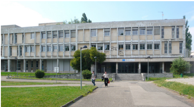
Faculté des Sciences, bâtiment de Chimie.
