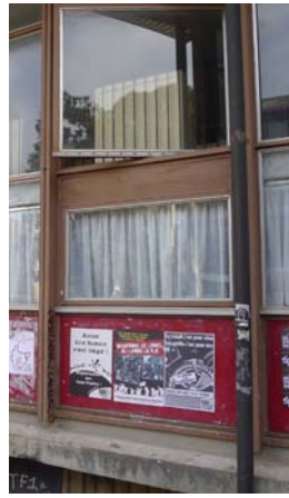
Menuiseries en niangon, panneau en émail, descente d'eau en acier
