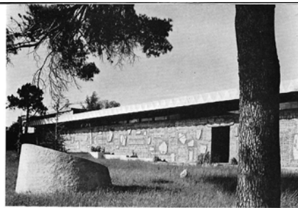
Vue d'ensemble du mur
