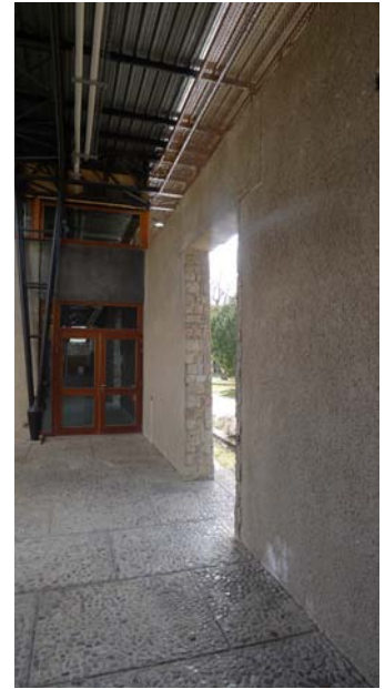
Mur enduit, dallage préfabriqué en calade. Structure tubulaire, menuiseries bois, panneaux revêtus de pâte de verre, couverture bac acier apparente
