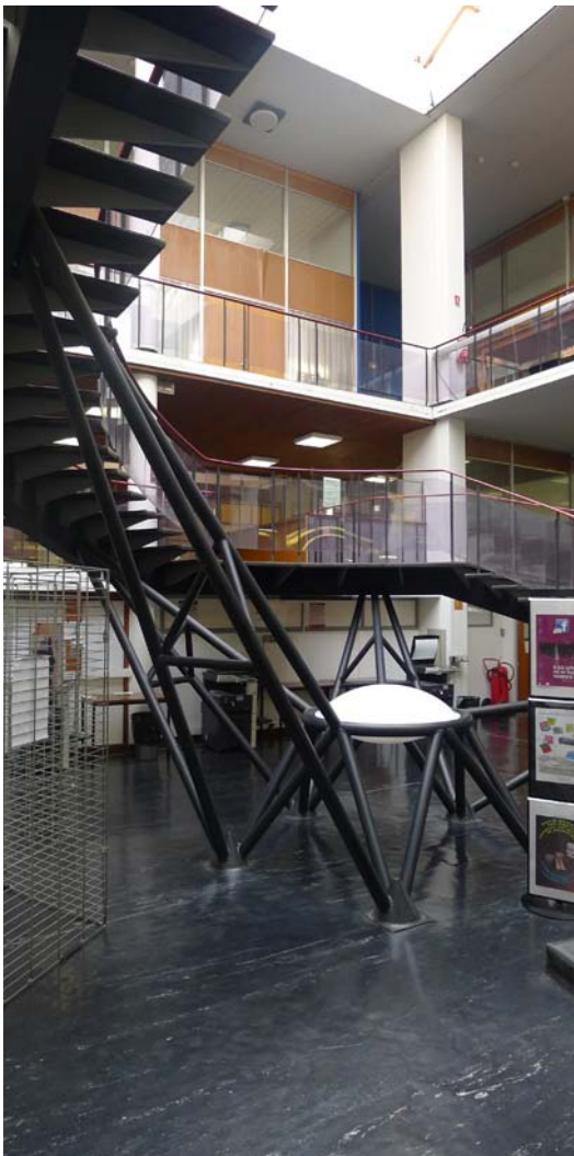
Structure tubulaire en acier de l'escalier de la bibliothèque
