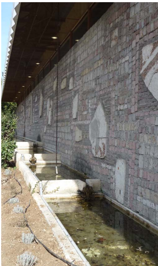
Bassins en cascade au pied du mur dans lequel se déversent les eaux de pluie dont la descente est assurée par des chaînes.
