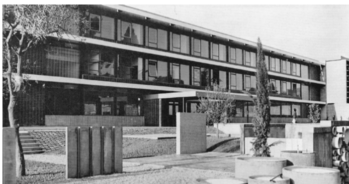
Le bâtiment de l'administration et des salles de travail avec le jardin du labyrinthe au premier plan. 1969
