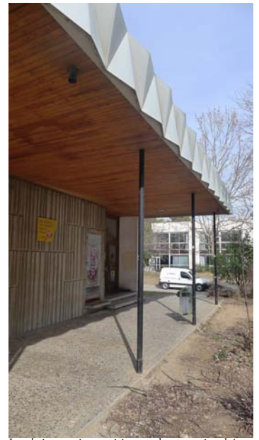
Lambris en pin maritime, tube en acier, béton brut et bardage de rive en tôle d'aluminium plié
