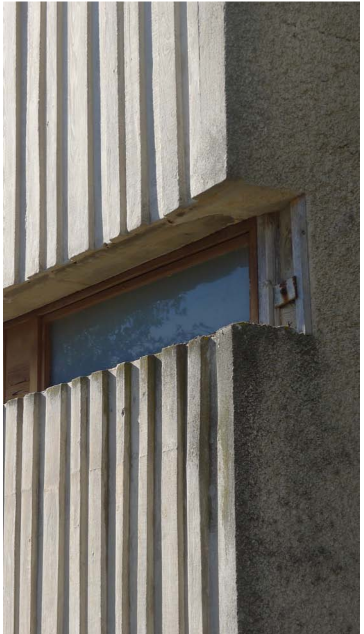
Éléments nervurés, moulés et préfabriqués en béton brut, et menuiseries bois
