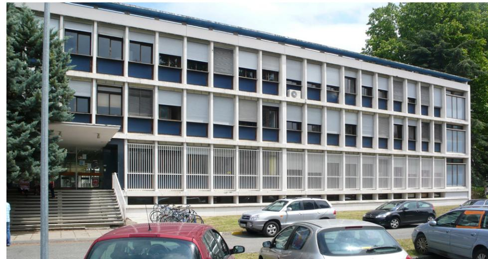
Le bâtiment type de recherche est d'une grande simplicité de conception. Il s'agit d'une barre de trois niveaux au-dessus d'un sous-sol surélevé, distribuée par un couloir central dans sa longueur, avec une cage d'escalier médiane et deux cages d'escalier aux extrémités pour assurer les circulations verticales.
