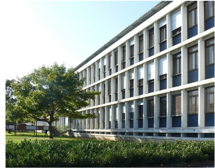
Le bâtiment type de recherche est d'une grande simplicité de conception. Il s'agit d'une barre de trois niveaux au-dessus d'un sous-sol surélevé, distribuée par un couloir central dans sa longueur, avec une cage d'escalier médiane et deux cages d'escalier aux extrémités pour assurer les circulations verticales.
